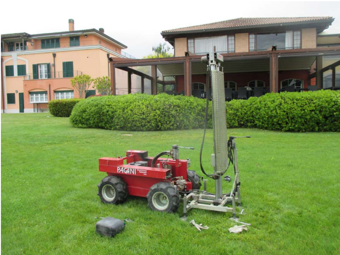
Foto 1: ubicazione prova DP 1
